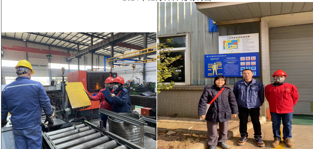
2024年12月20日现场检测
