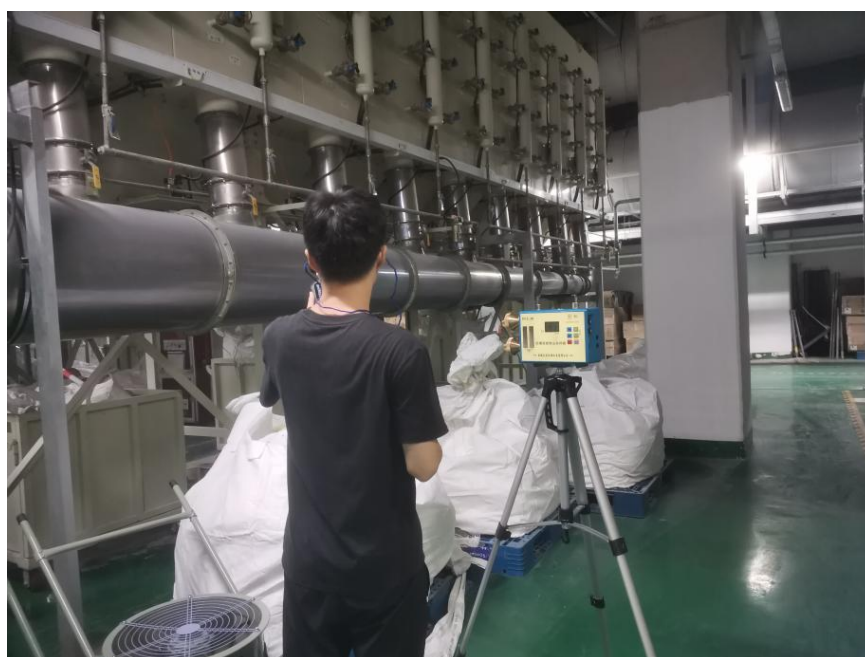
现场检测照片
